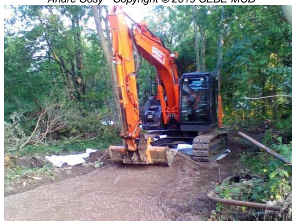
Epandage d'un gravier de lave à la pelle mécanique (26/08/2019) André Cosy - Copyright © 2019 CEBE-MOB
